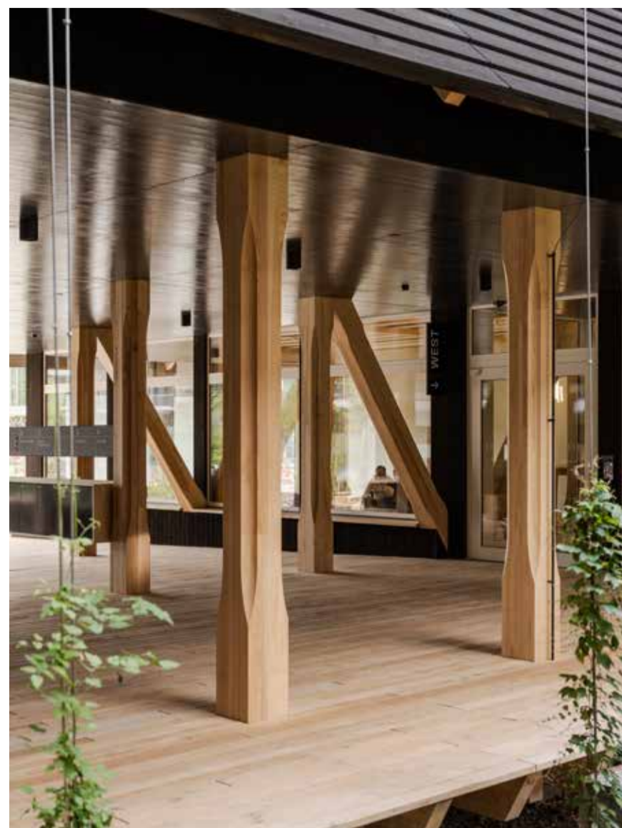
Das Holztragwerk prägt die Atmosphäre des Gebäudes bis ins Erdgeschoss.
