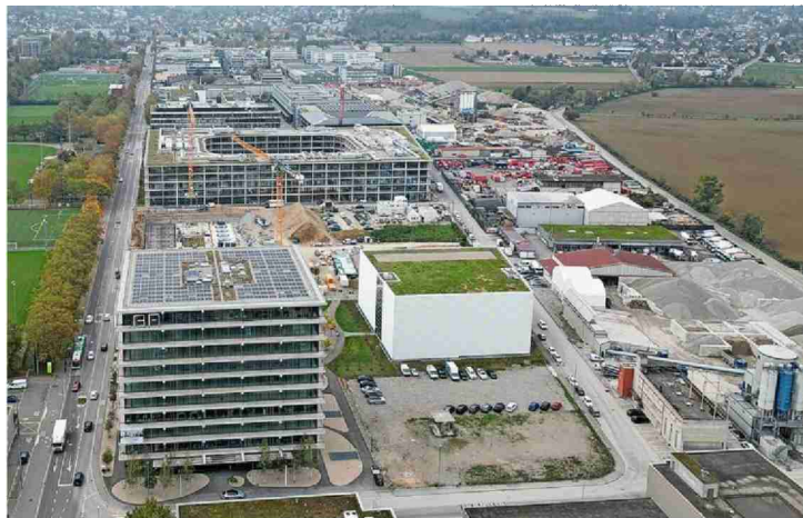
Der Allschwiler Innovationspark erhält ein neues Labor- und Bürogebäude: Heute ist offizieller Baustart. Foto: Pino Covino
