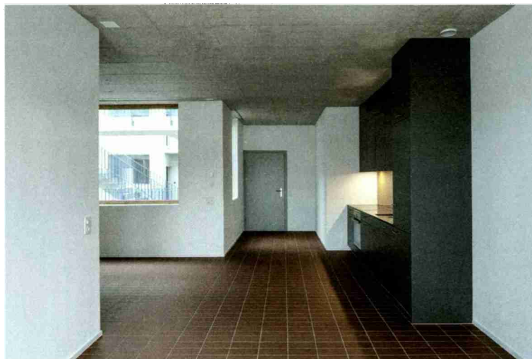
Einfache Materialisierung mit Plattenboden, Abrieb und Sichtbeton.
