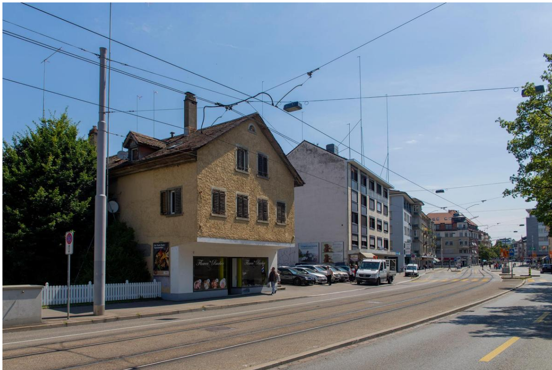
Die Bauvisiere stehen schon: An diesem Ort beim Lindenplatz in Altstetten soll die neue Wohnüberbauung entstehen, mehrere Häuser werden abgerissen. Foto: Anna-Tia Buss
