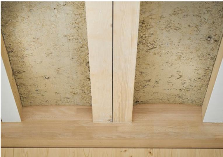
Innovativ und tragfähig wie Beton: Die Deckenkonstruktion aus Holz und Lehm, hier im Mock-up des «Hortus» zu sehen.
