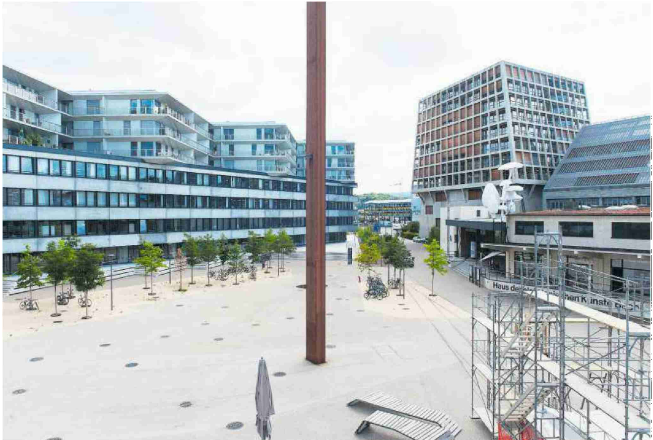
Das Dreispitzareal mit dem Transilager (links) und dem «Helsinki-Dreispitz» von Herzog & de Meuron.
