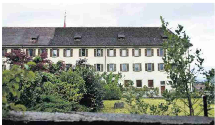
Das Kapuzinerkloster in Stans soll für gut sieben Millionen Franken saniert werden.
